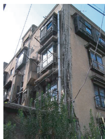
解体直前の 同潤会三ノ輪 アパート 崩れそうな姿
